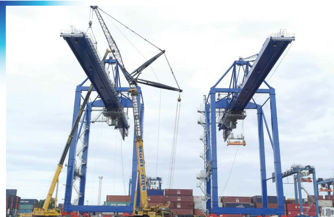
Thi công lắp dựng cầu Kocks tại Cát Lái Erection Kocks Crane in Cat Lai
