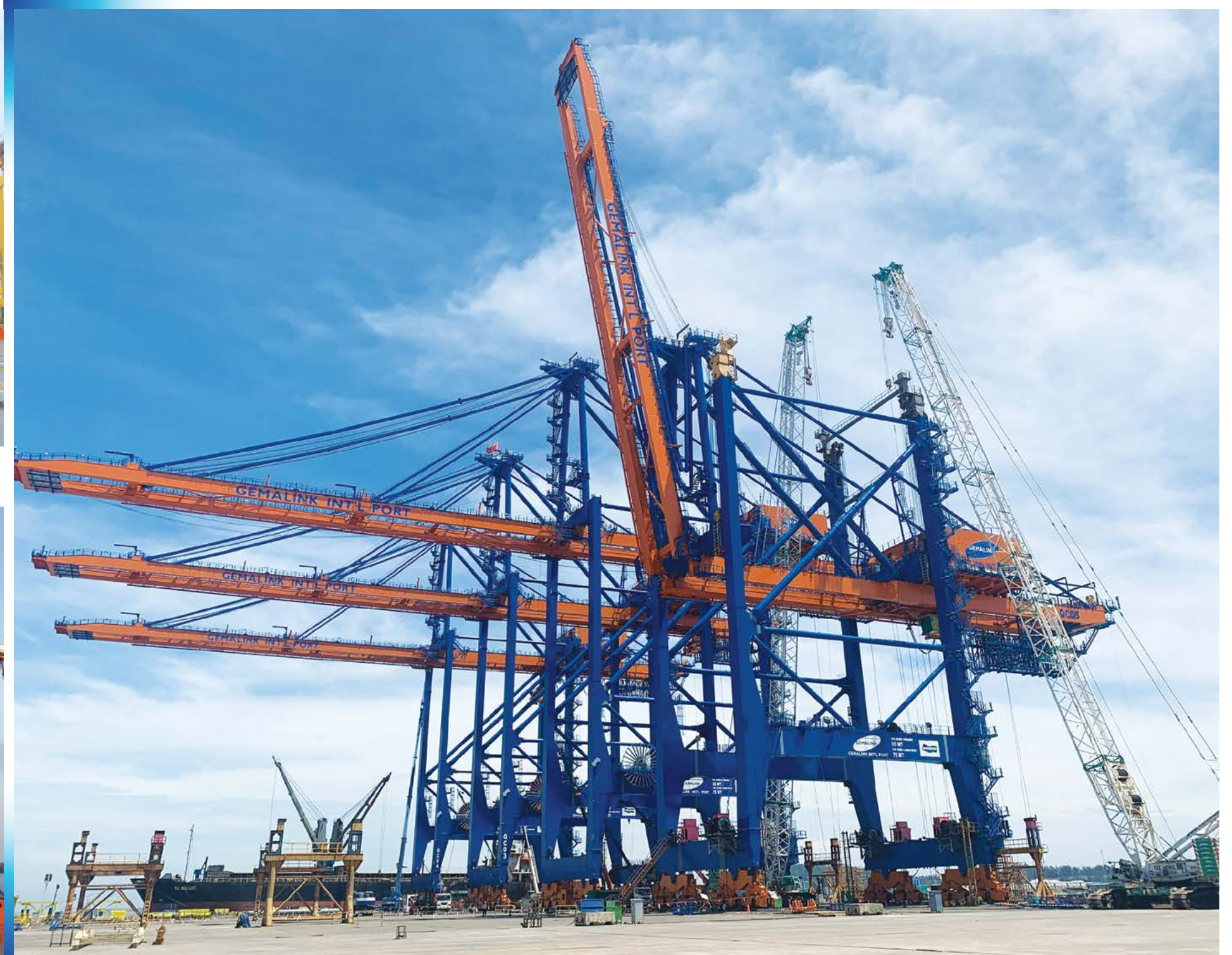
Lắp dựng, vận chuyển 6 cầu tại Doosan Vina Erection and Transportation of 06 RMQC - DOOSAN VINA
